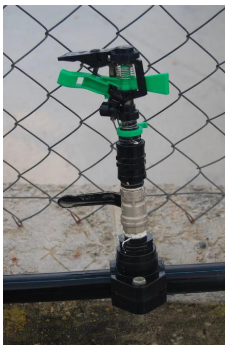
Fig. 6/A - particolare dell'ugello per la nebulizzazione dell'acqua
